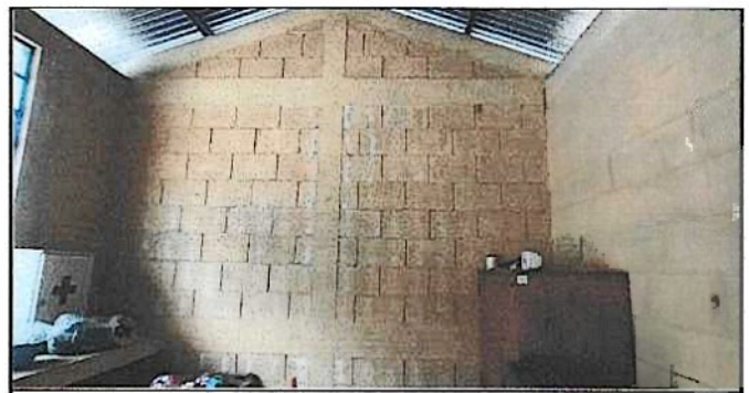
Foto 6: Cernido de pared en area de cocina para mejorar la higiene y evitar la humedad.
